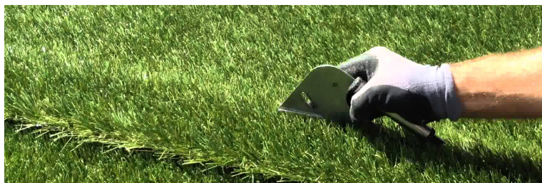
Рис. 1. Подрезка рулонного покрытия
